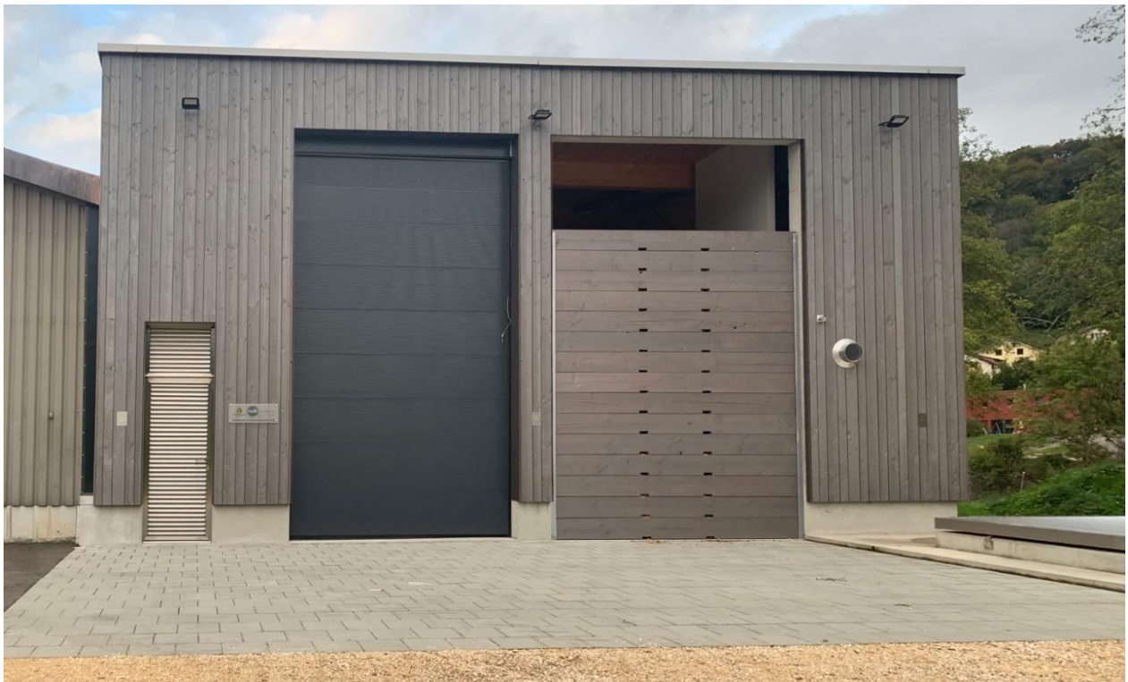
Centrale de chauffe au Chemin des Saules
