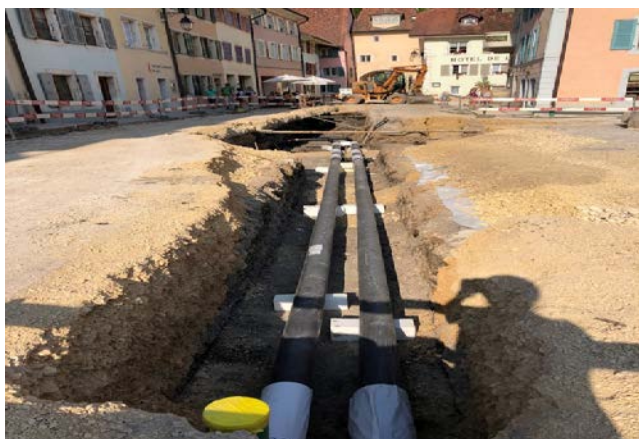
L'achèvement des travaux de génie civil Saint-Ursanne, le 9 novembre 2020
